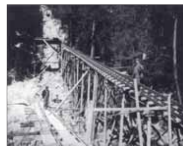
Bau Muottas Muragl Bahn 1903–1907
