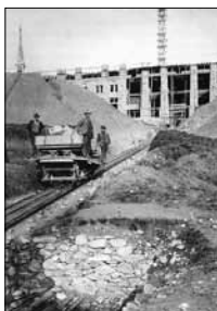
Bau Grand Hotel Unbek., 1903 15/30*
