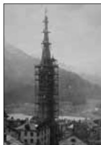
Turm der Dorfkirche im Bau Unbek., 1897 15/28
