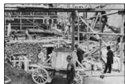
Bauarbeiten Via Maistra 1 Unbek., ca. 1925 15/29
